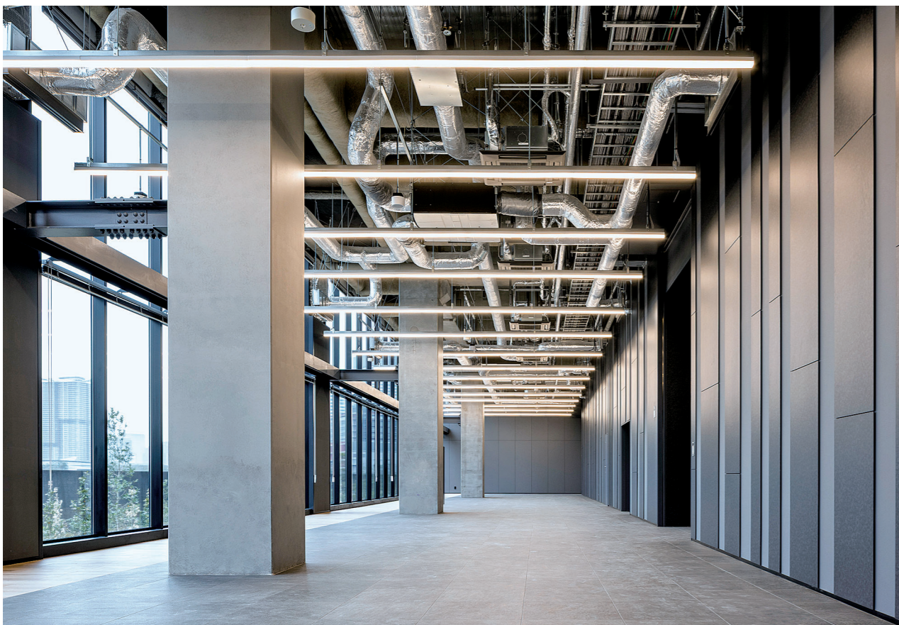
エントランスホール
