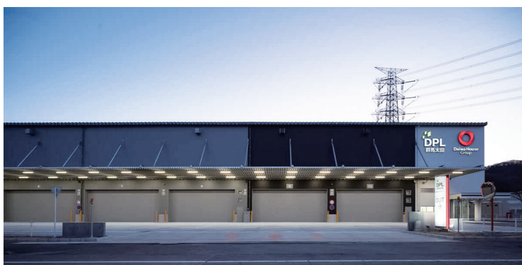
東側外観(夕景)
