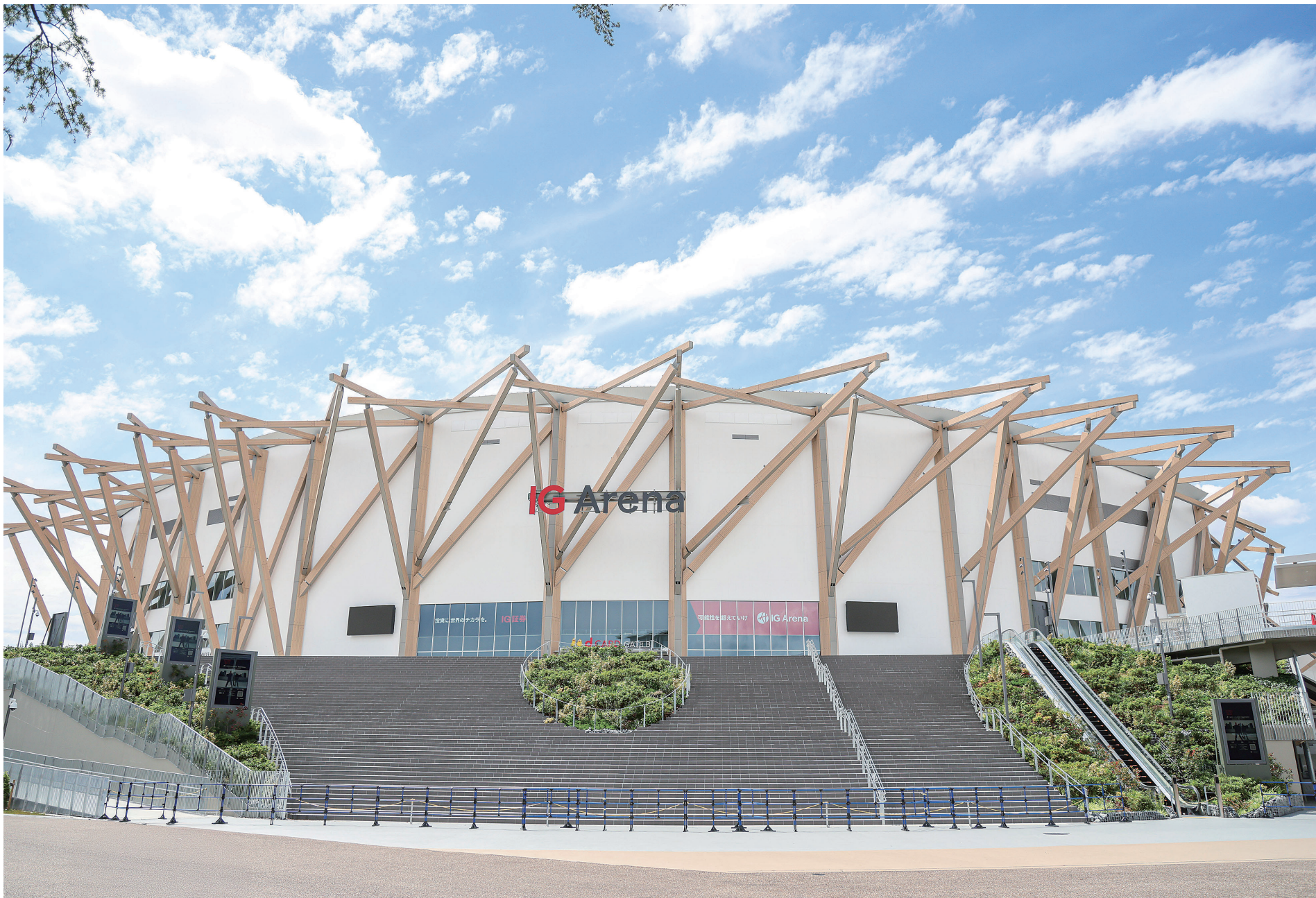
枝が張り出したような「樹形」が印象的な I Gアリーナの外観
