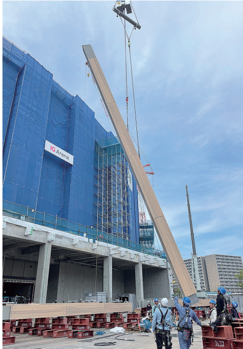
「樹形」鉄骨の建て方作業①②
