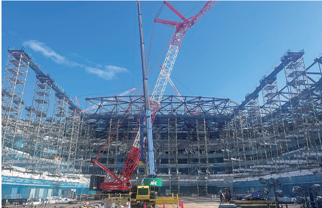
屋根鉄骨の建て方作業
