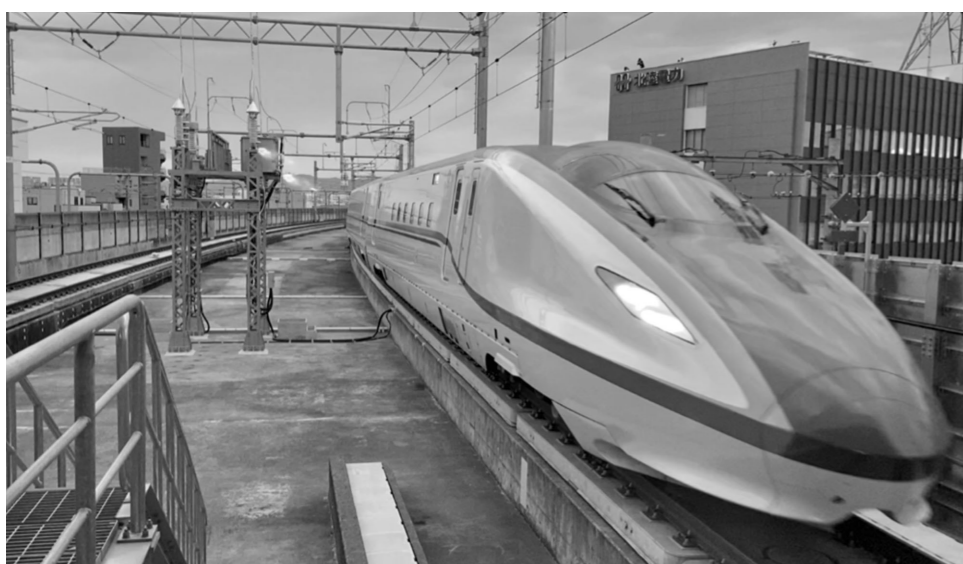
2024年3月の開業に向けて試験走行する北陸新幹線。金沢～敦賀間の125km(工事区間は白山車両基地～敦賀間113km)を延伸し、途中、小松、加賀温泉、芦原温泉、福井、越前たけふの各駅が設置される
