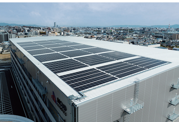
屋上 太陽光パネル
