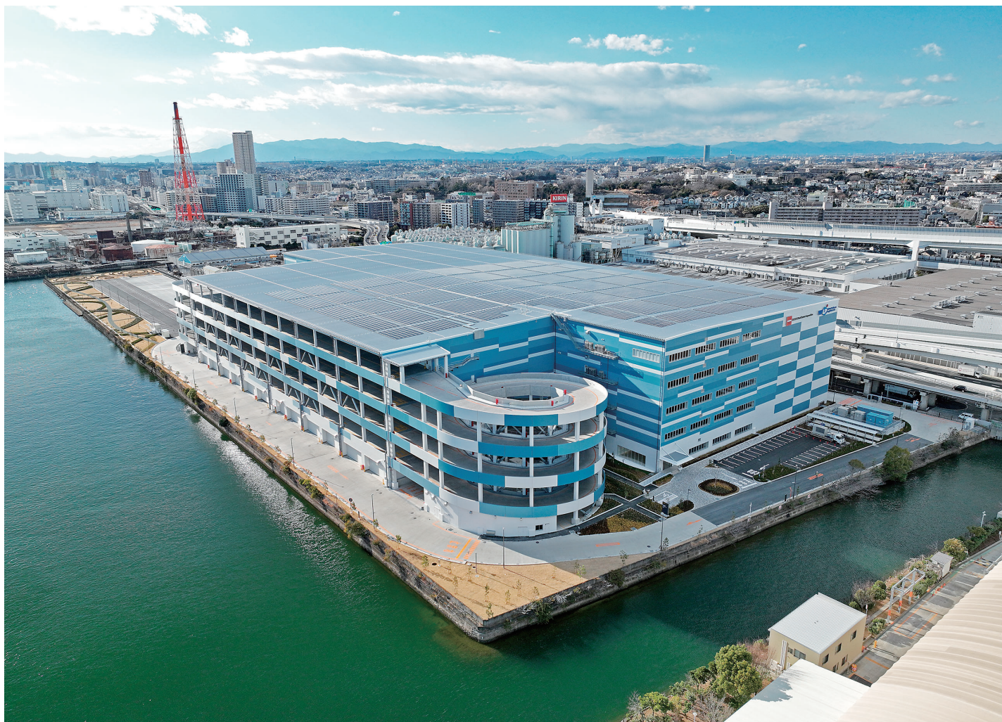
敷地南東から。屋上に最大2MWの発電を行う太陽光パネルを設置 (写真提供: 雁光舎)
