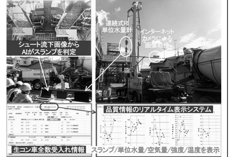
受入れコンクリートの品質の全数管理システム
