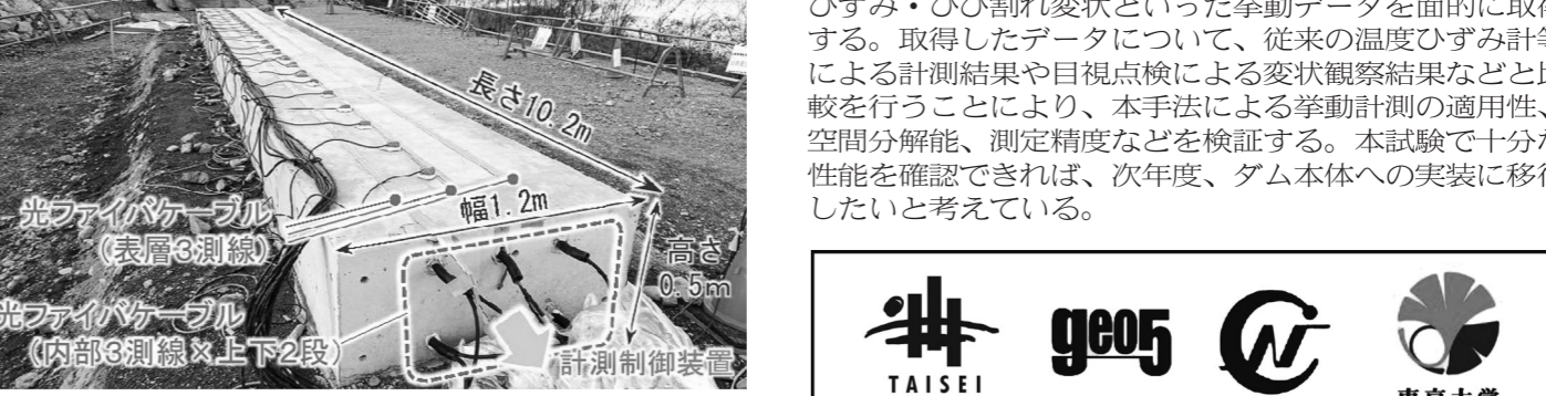
フェイススラブの模擬試験体
