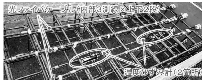
光ファイバーケーブルと従来のひずみ計との比較
