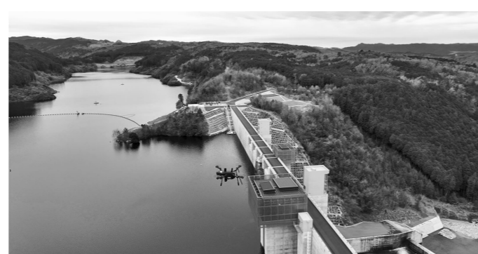
川上ダム湛水域自動巡視実証状況
