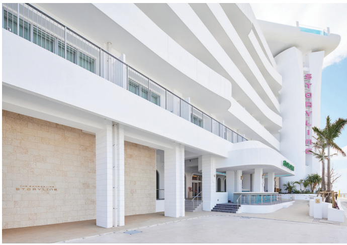
車寄せスペース
