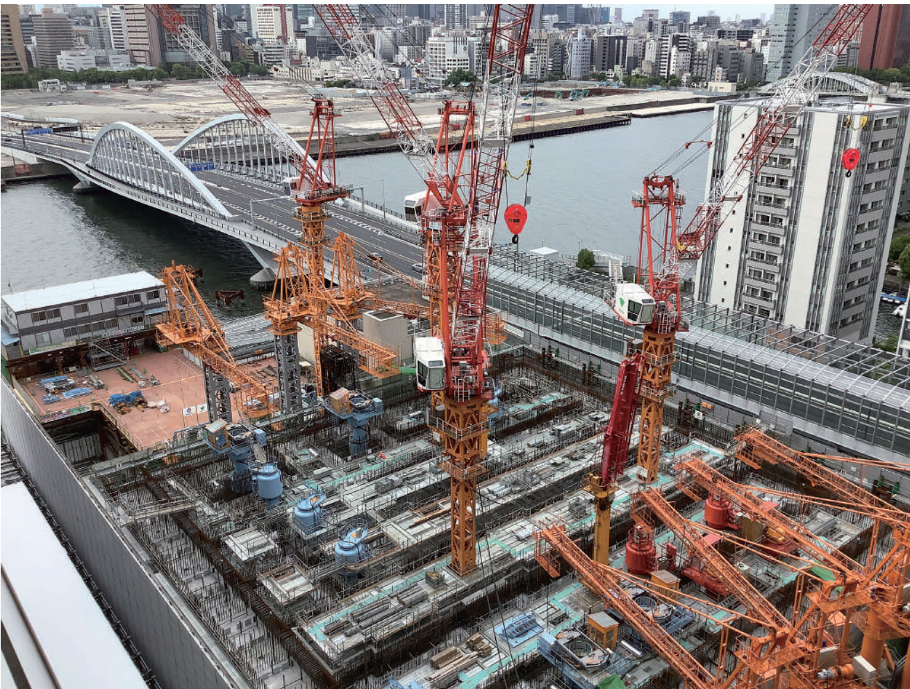
4台のタワークレーンで効率的に施工
