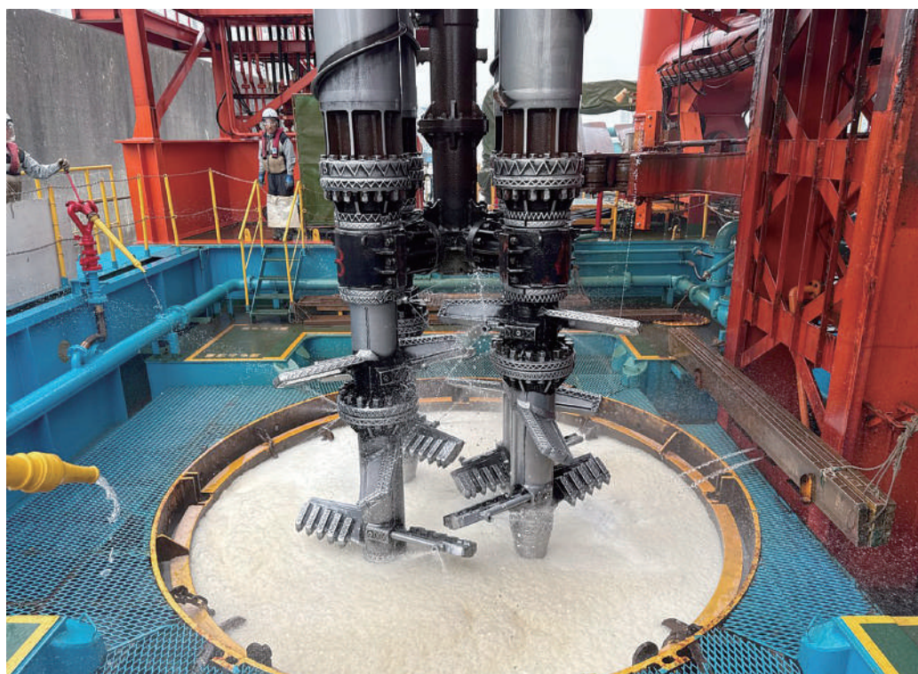
深層混合処理船攪拌翼
