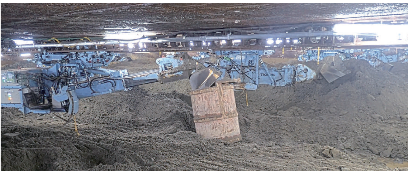
掘削が進む作業室内部
