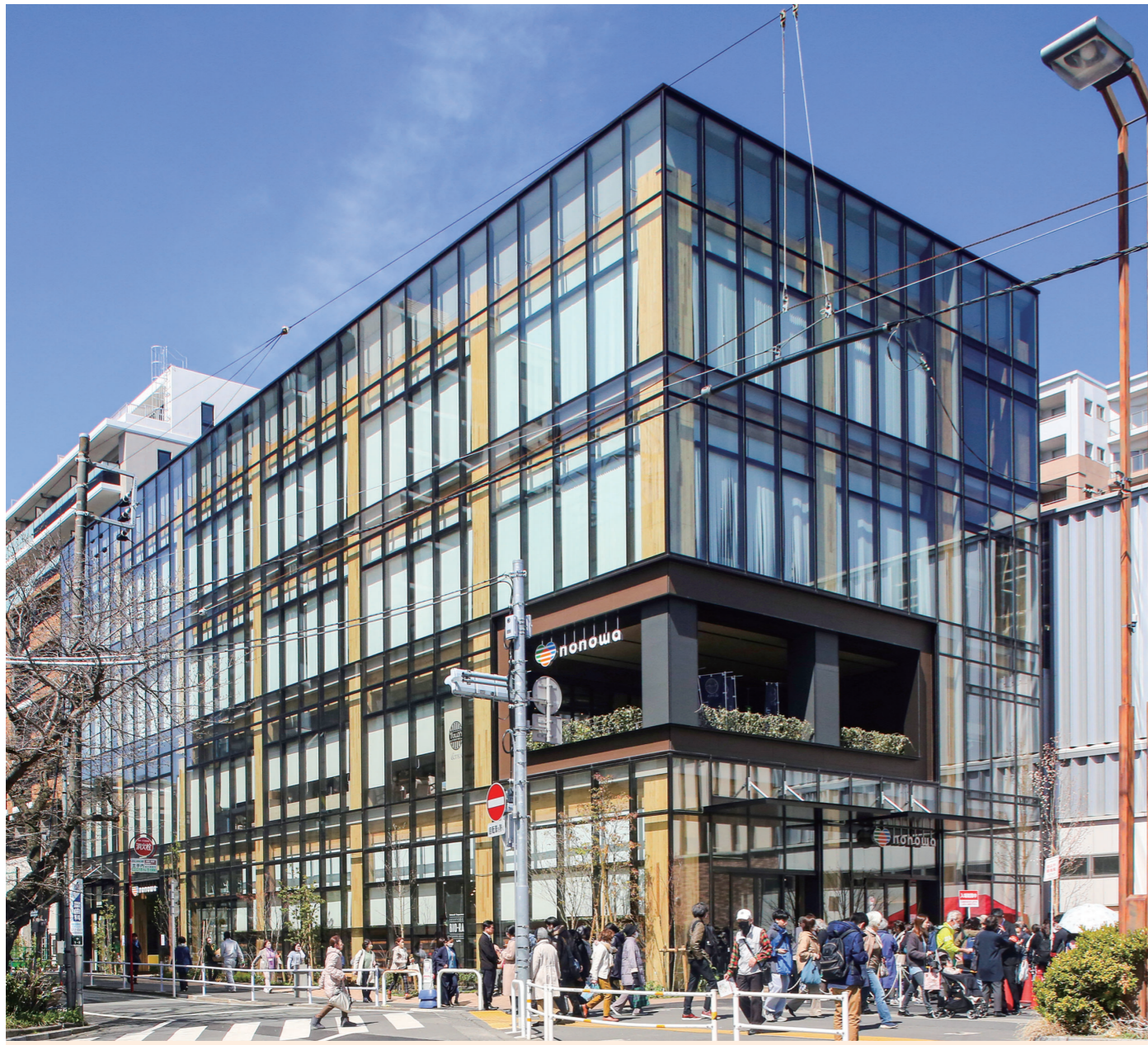
基本設計/JR東日本建築設計 実施設計・施工/大林組
