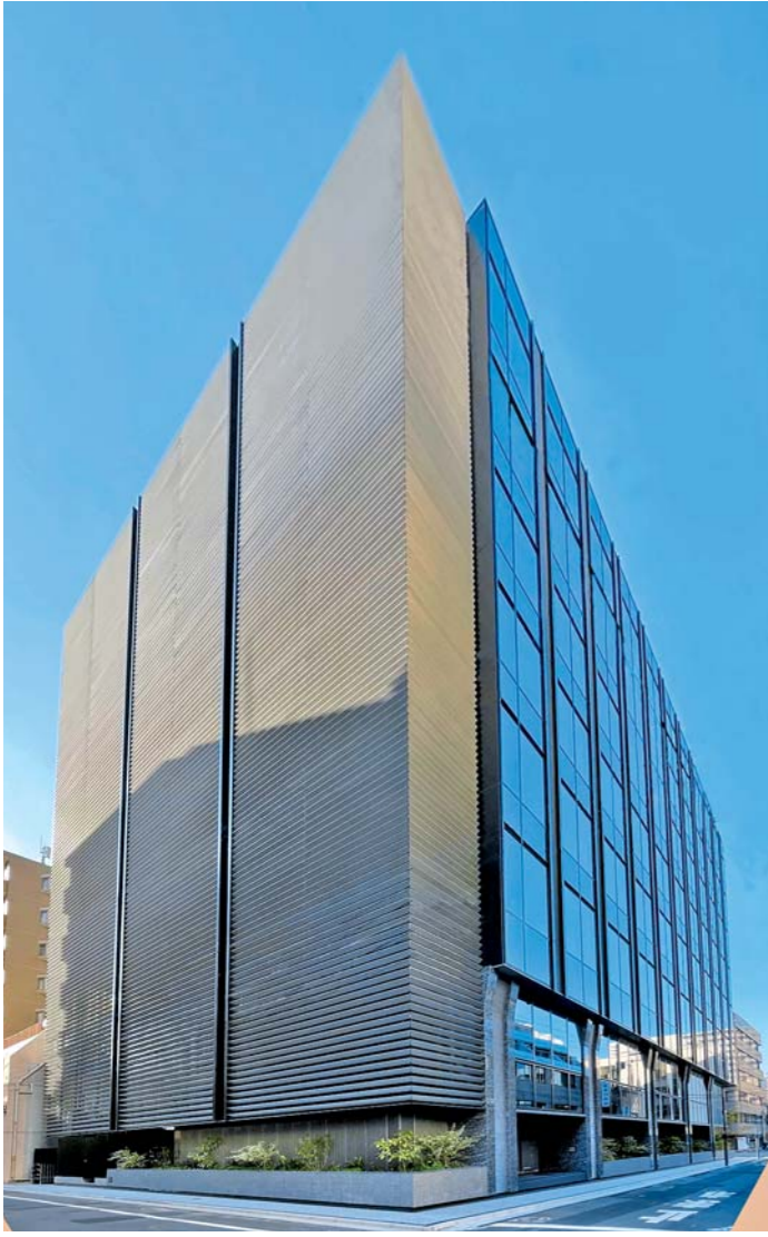
南面・東面外観
