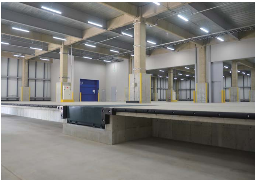
1階 トラックバース
