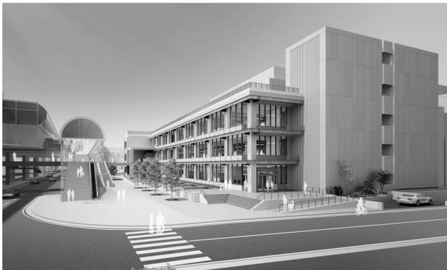
少ない手数でストックの価値を高める「費用対効果の大きな減築」を目指す。①施設中央に大きな吹抜を設けることで採光を確保し、明るく快適な屋内環境を生み出す②既存の地下空間をクールヒートピットに転換し地中熱利用を行うなど、既存の骨格を生かした環境配慮手法により、千葉市初のストック型ZEB Readyを目指す③全面道路(臨港プロムナード)沿いの1スパンを減築し、歩道の安全性や見通しを改善する。
