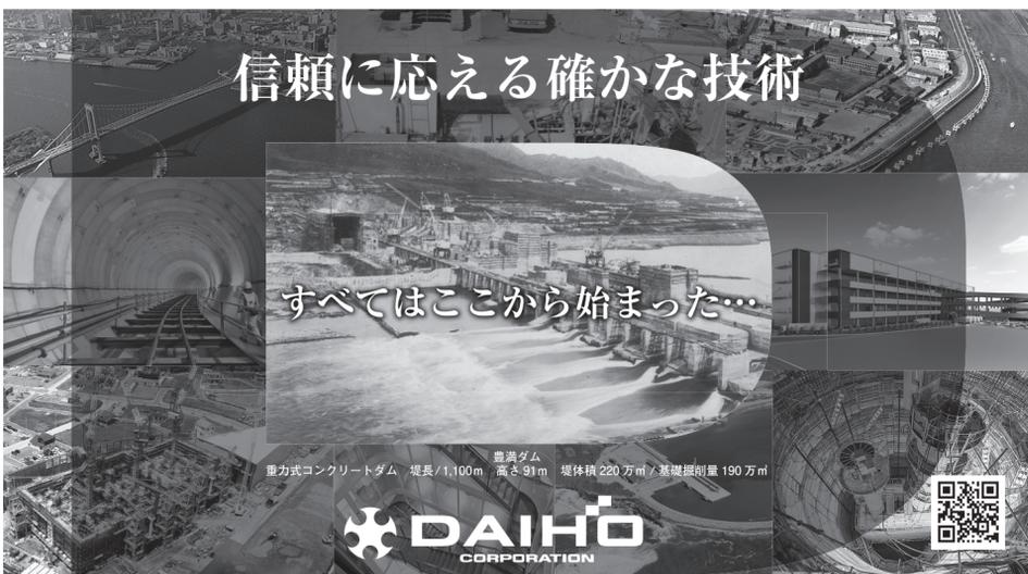
豊満ダム 重力式コンクリートダム 堤長/1,100m 高さ/91m 堤体積 220万m³ 基礎掘削量 190万m³
