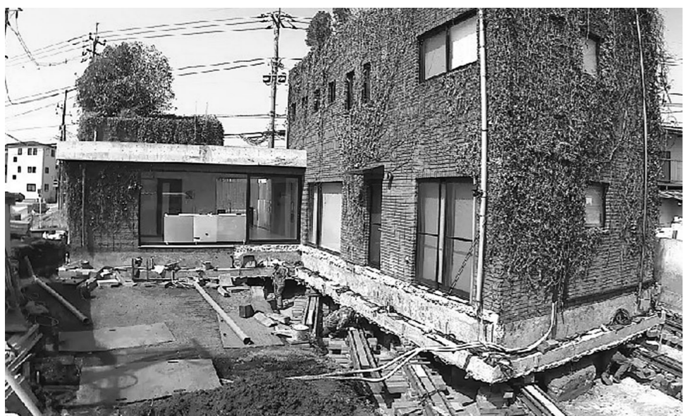
K氏邸移転工事 道路拡張事業によって鉄筋コンクリート造2階建て住宅(460t)を移転した
