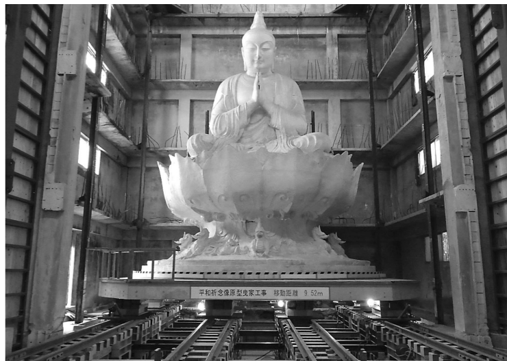
平和記念像の修復保存移動工事 (沖縄県宜野湾市)
