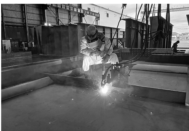
主桁溶接状況
