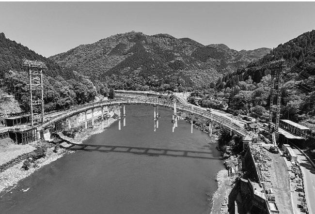
鉛直材の施工状況
