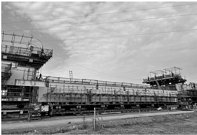
吊上げ架設前
