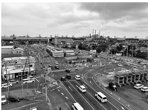
大ブロック架設を実施する笹越橋交差点部の現況
