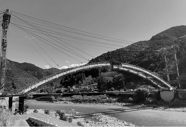
アーチリブの架設
