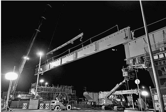
交差点上夜間架設
