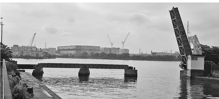
名古屋港跳上橋
