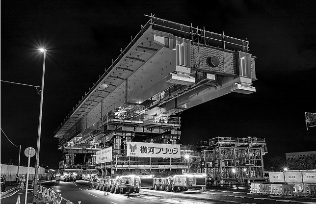
多軸台車による桁架設
