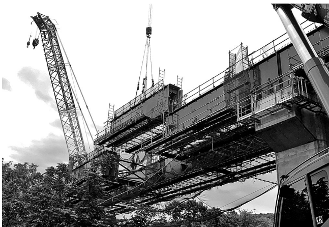
落し込み架設
