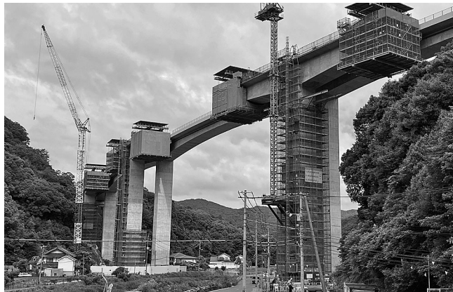
ワーゲンによる張出施工を展開
