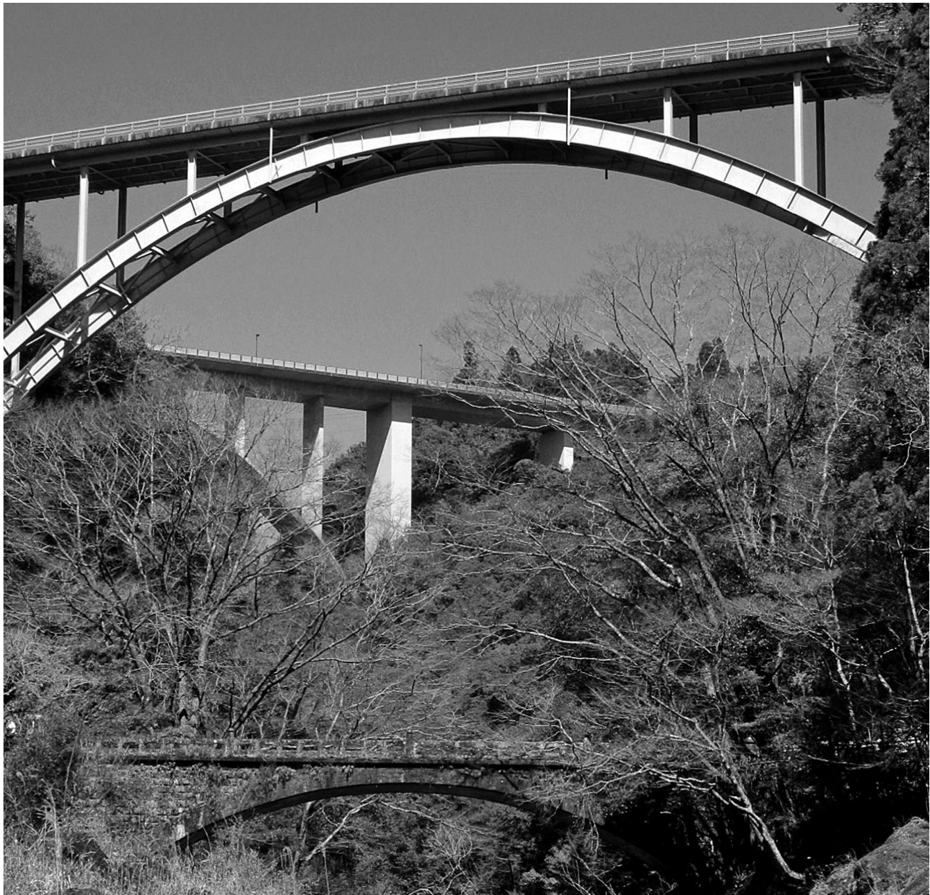
高千穂峡(宮崎県)に架かるアーチ3橋。手前から大正時代竣工の神橋、昭和時代竣工の高千穂大橋、平成時代竣工の神都高千穂大橋。(2026年3月撮影)
