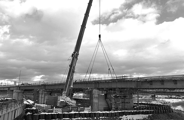
新設桁の架設状況
