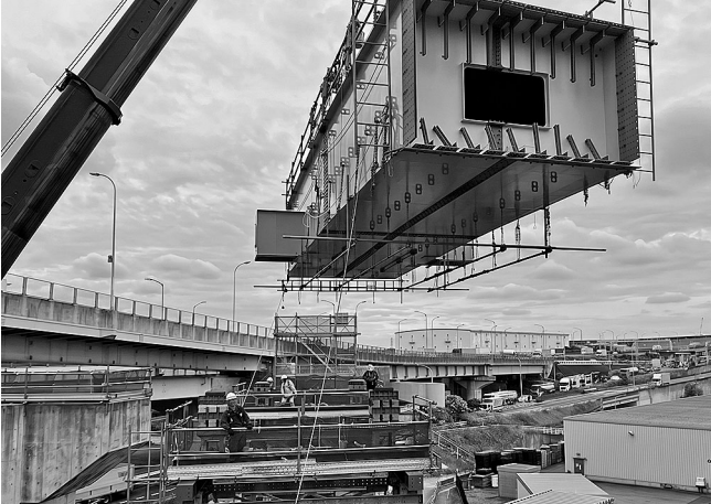
既設JCTをばねの桁の架設作業
