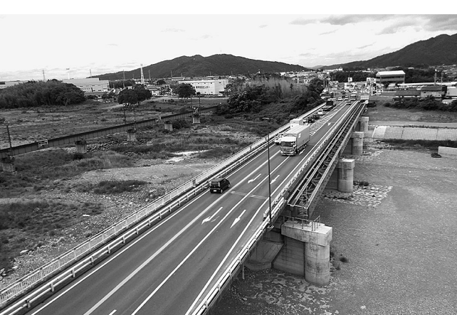
橋長134mの新設桁の架設が完了
