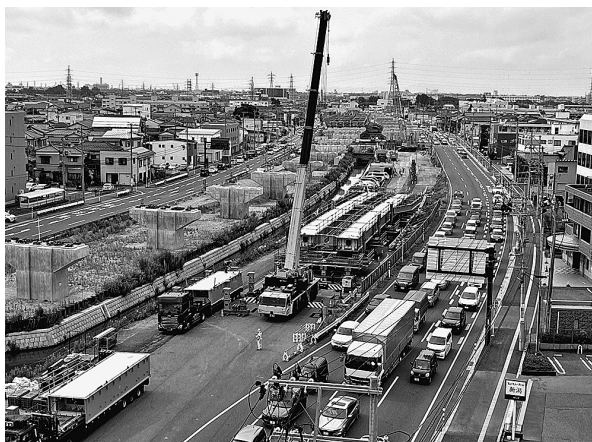
大ブロック地組み桁(上り線)の地組み状況
