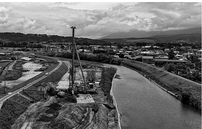
地盤改良工の施工状況
