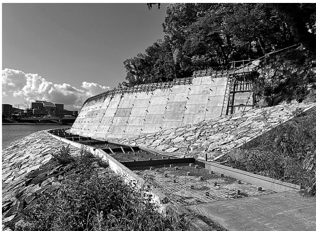
現場全景(上流より下流望む)
