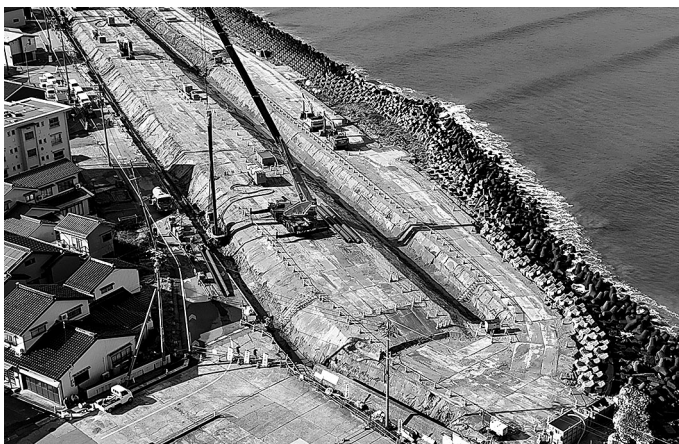
液状化対策施工状況
