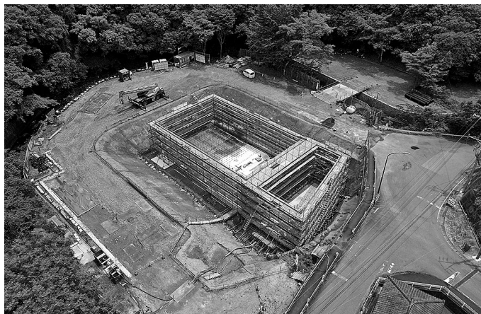
排水機場全景
