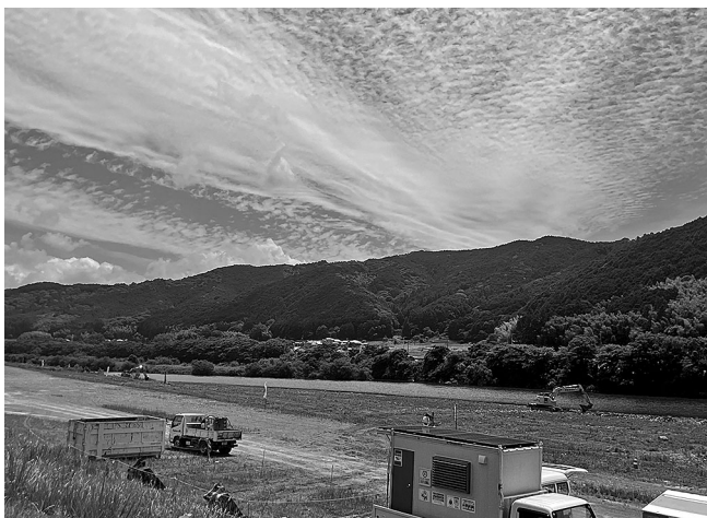
下ノ村箇所掘削状況(6月)
