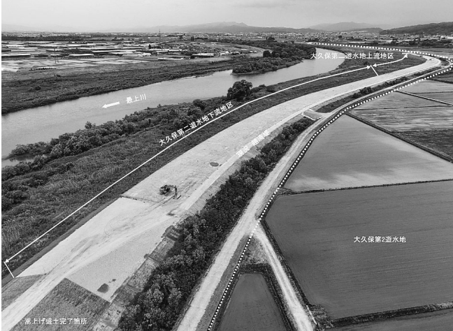
施工現場の全景
