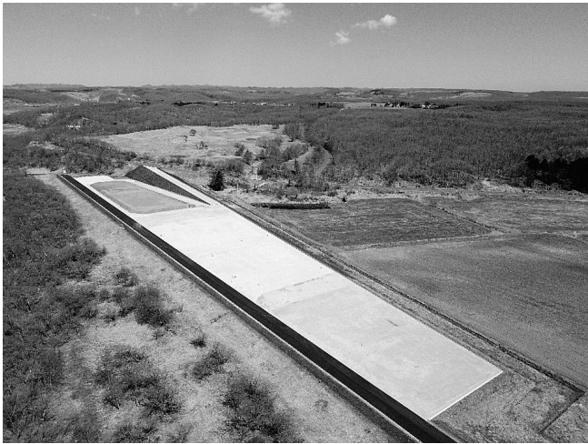
十勝太地区(着工前)
