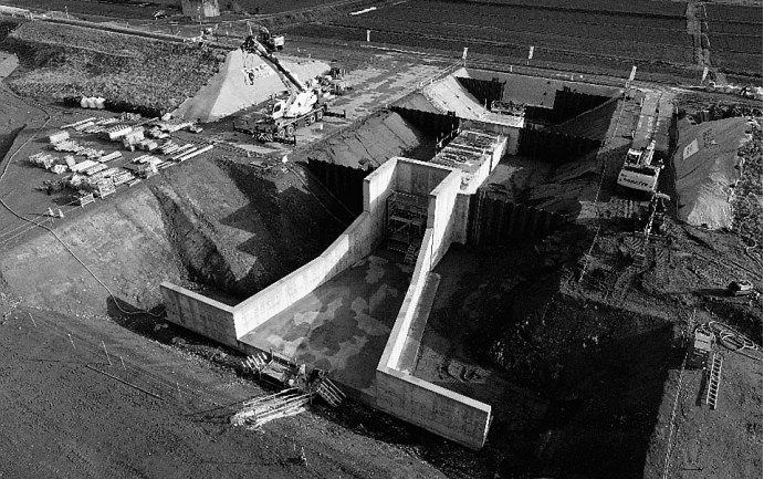
埋め戻し前（全景）
