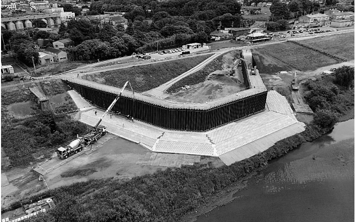
施工現場全景
