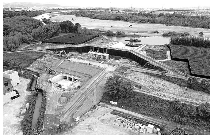
二重締め切り堤防を設置し工事を推進
