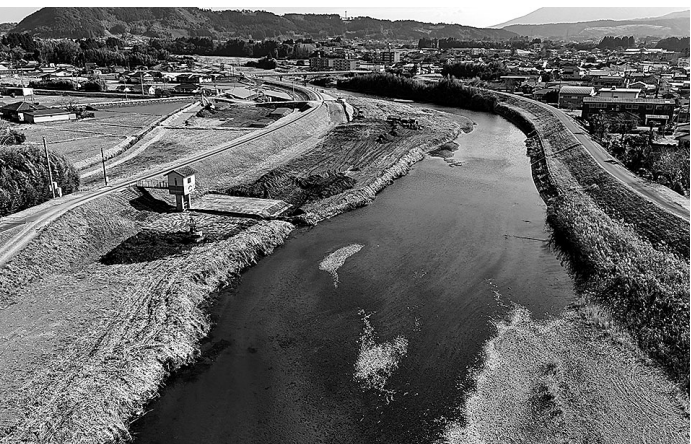
工事着手前の施工箇所
