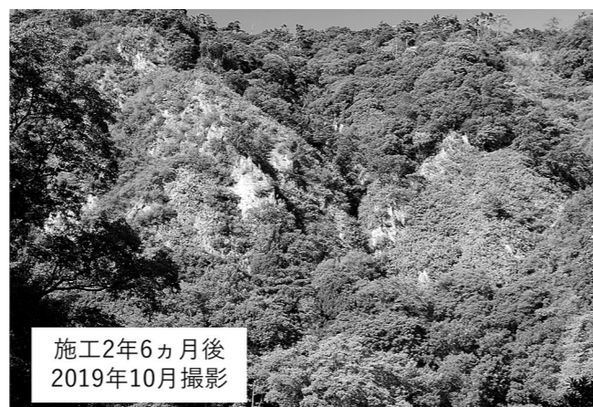
地震災害で発生した岩盤面の緑化事例(斜面樹林化工法ハイグリーンショット仕様)
