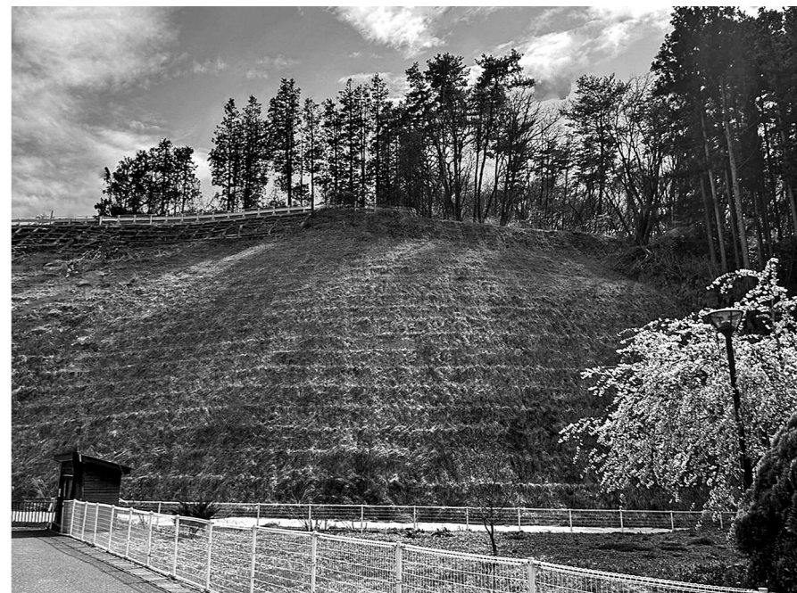
全面緑化型のり面保護工「GTフレーム工法」の施工事例
