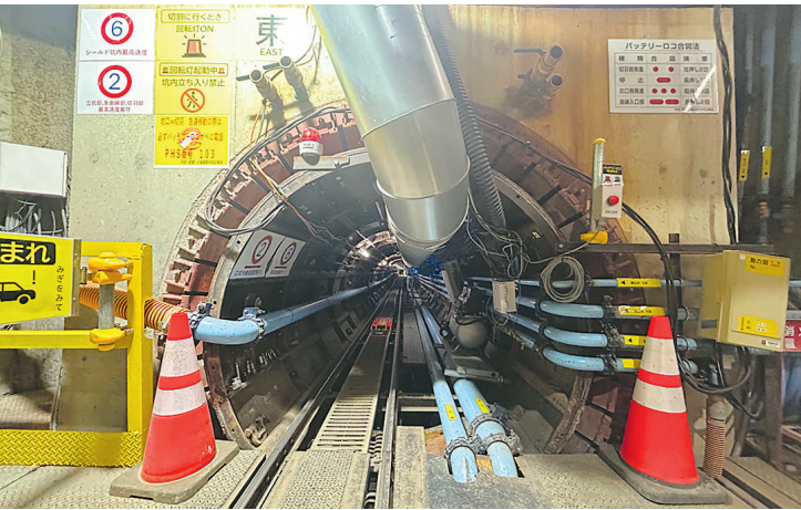
シールド坑口
