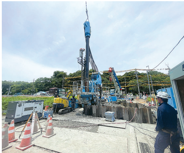
到達立坑鋼鉄板の施工
