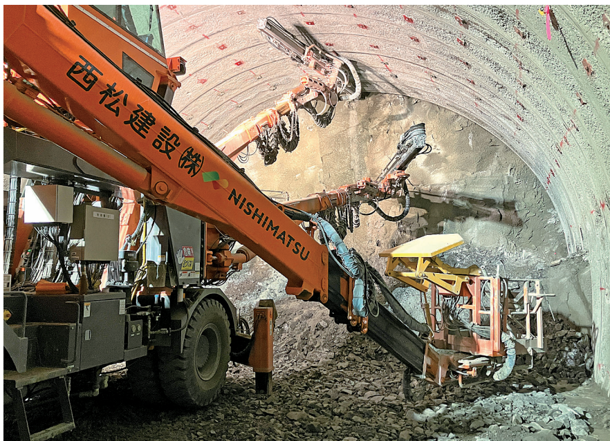
コンピュータージャンボによる全自動穿孔
