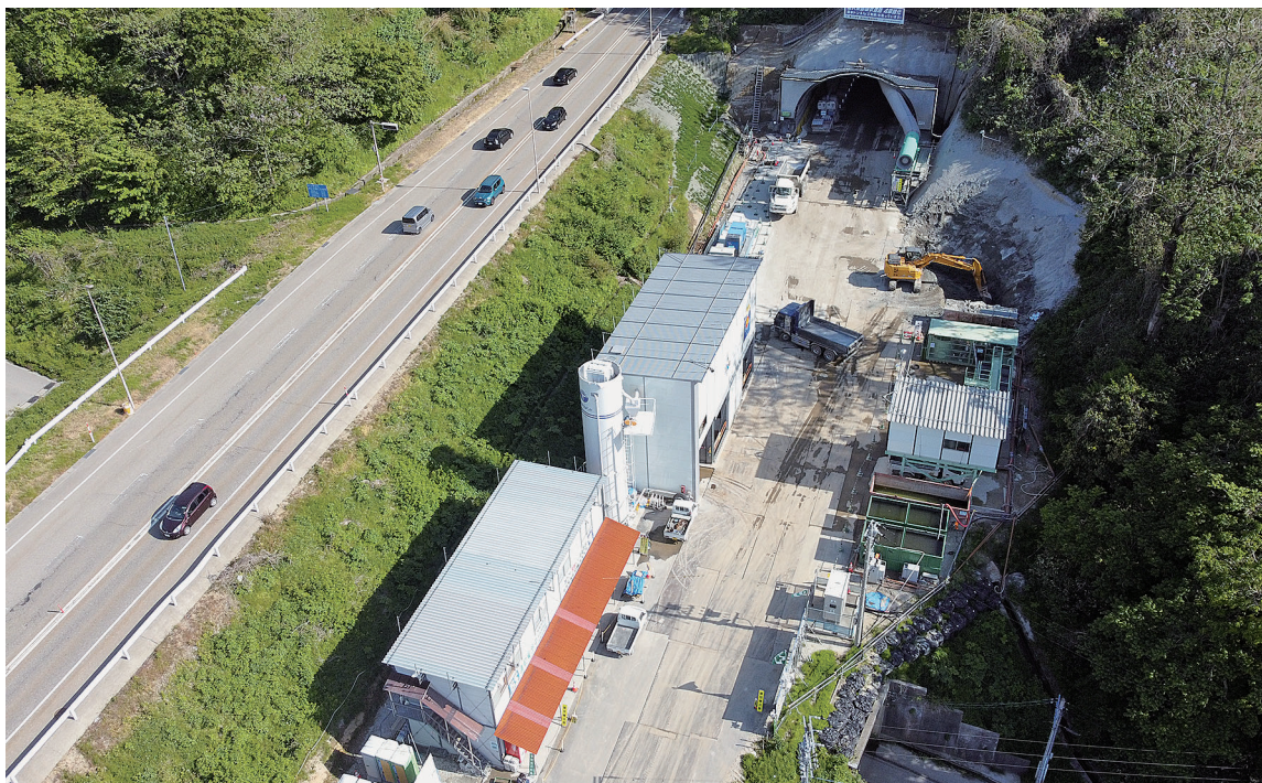
現場全景(起点側)
