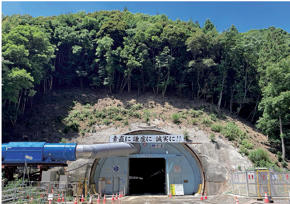
起点坑口全景
