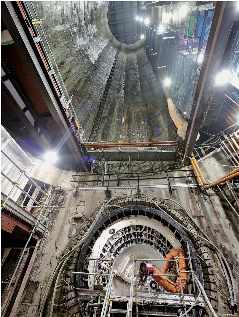
地下60mから立坑を見上げる
