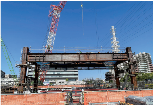
採用した鉄骨建て方のユニット工法
