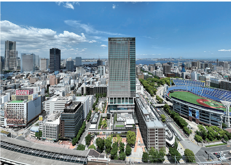
タワーにはエリア最高層のオフィスを備える
