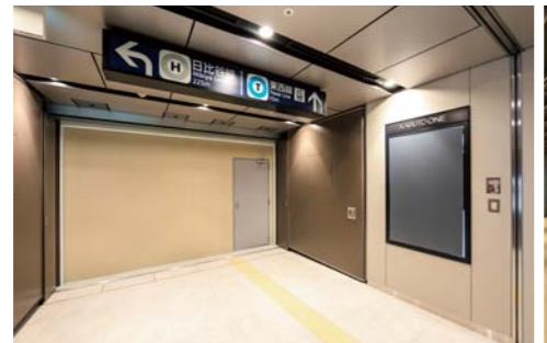
地下鉄接続部
