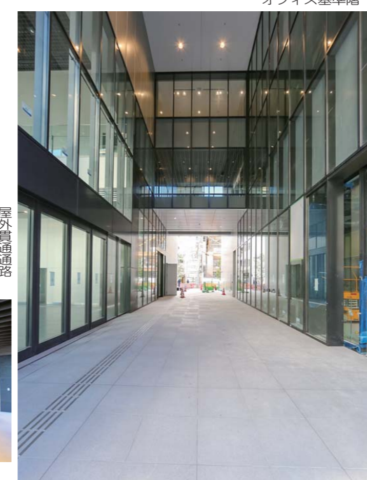
屋外貫通通路
