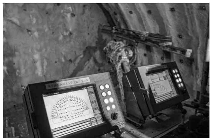
コンピュータジャンボによる穿孔の様子
