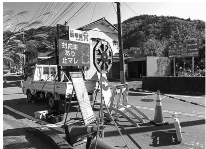
LED誘導システム
