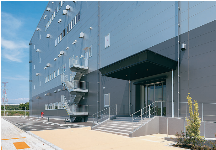
西エントランス
