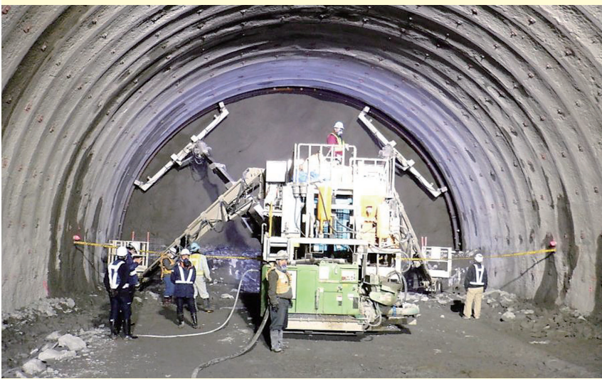
鋼製支保工建て込み作業の切羽無人化施工状況
