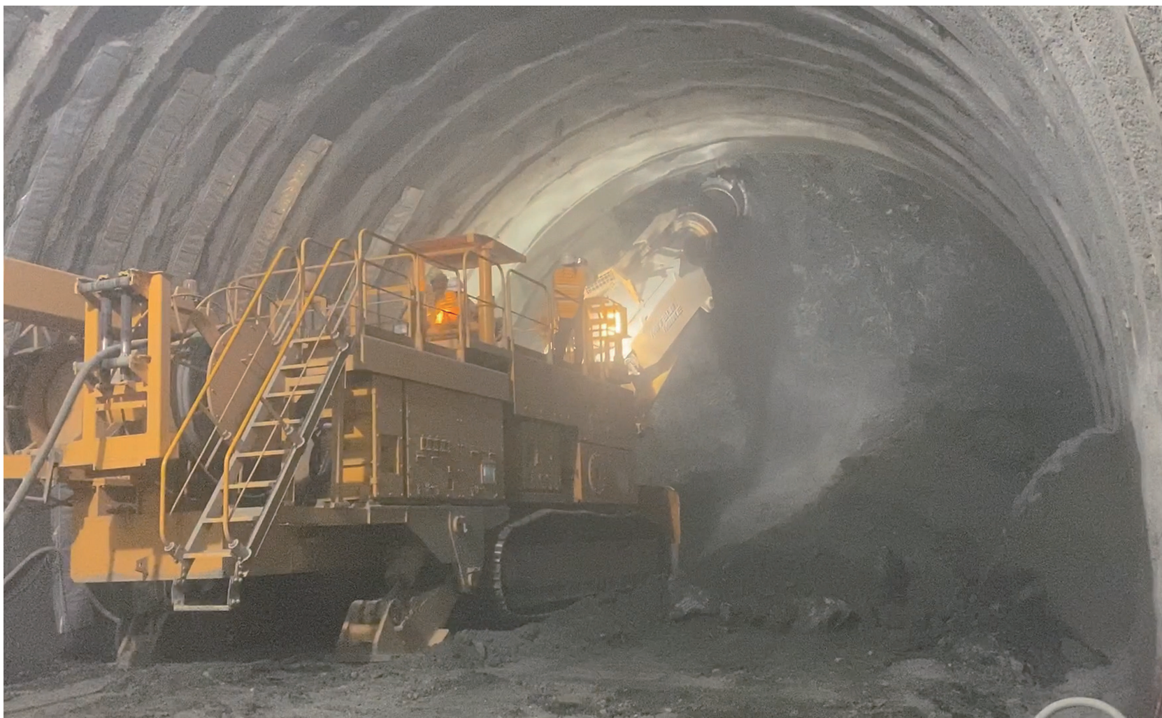
赤坂トンネル上り線貫通時の切羽
