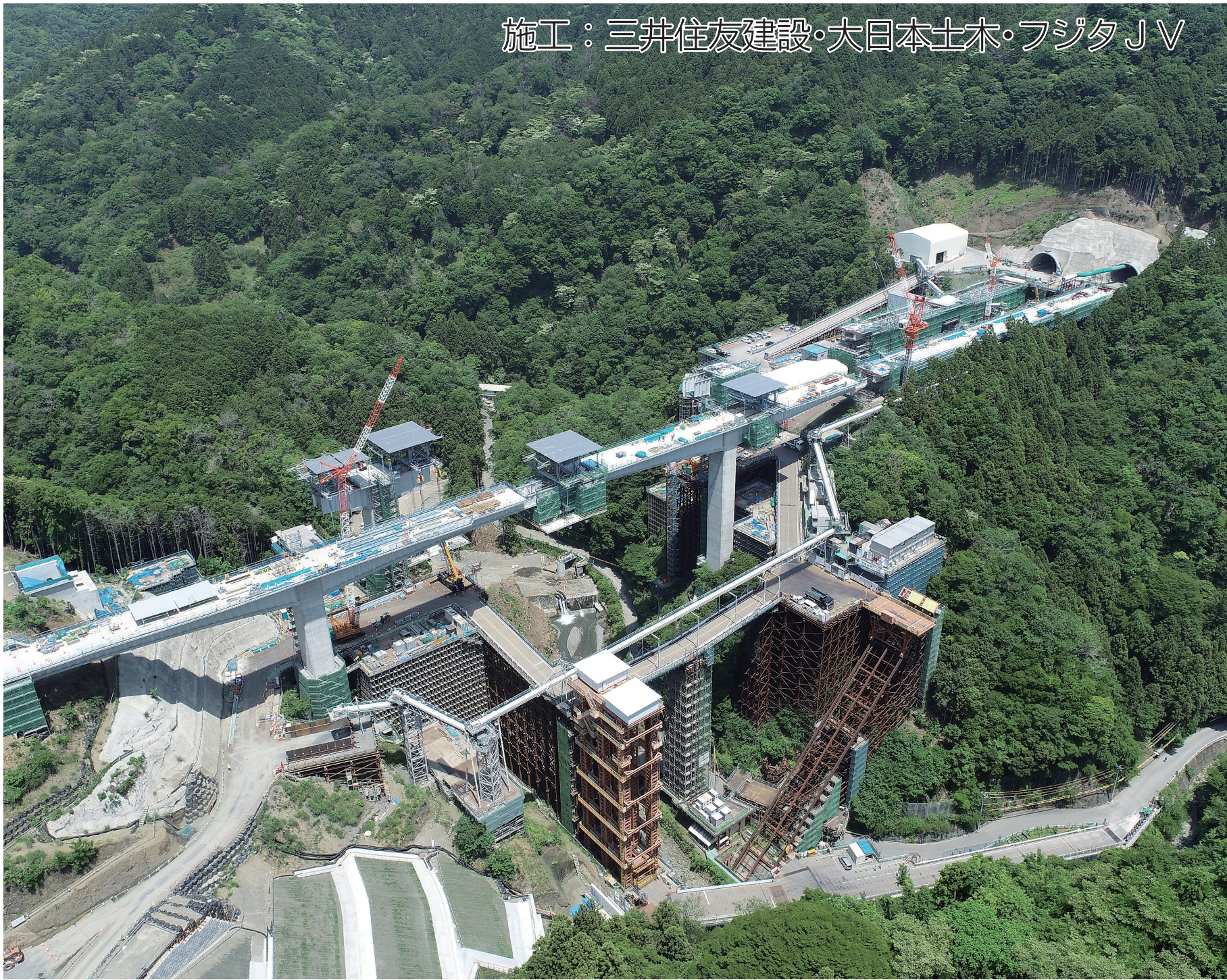
山北皆瀬川現場全景（右奥が赤坂トンネル坑口）
