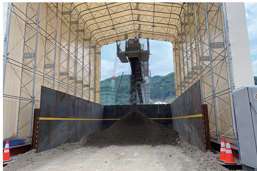
重金屬含有土の仮置き場
